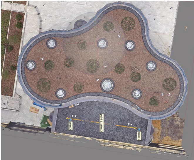
Bild 19 Hoch aufgelöste Punktwolke mit Referenzpunkten High resolution point cloud including reference markers
