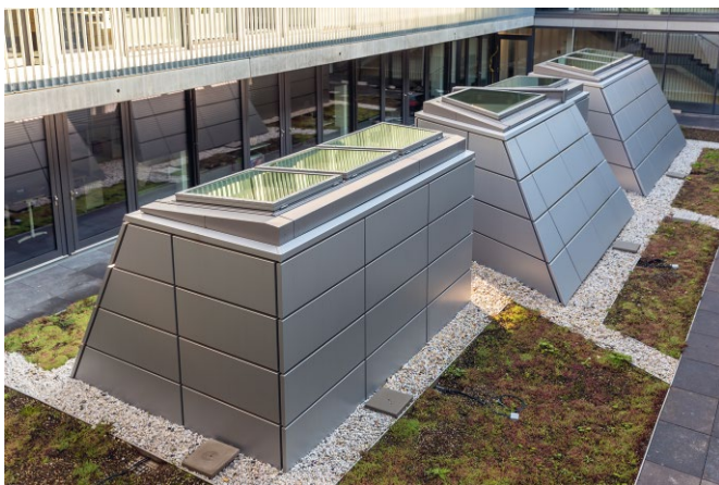
Bild 23 Architektonische Tageslichtanlage der Hochschulbibliothek Gammersbach Architectural daylight system at university library Gammersbach
