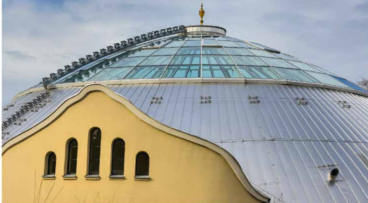
Die konisch bogenförmig gerundeten Kuppelscharen des beeindruckenden Kuppeldaches wurden bei Krehle in Landsberg vorgefertigt
